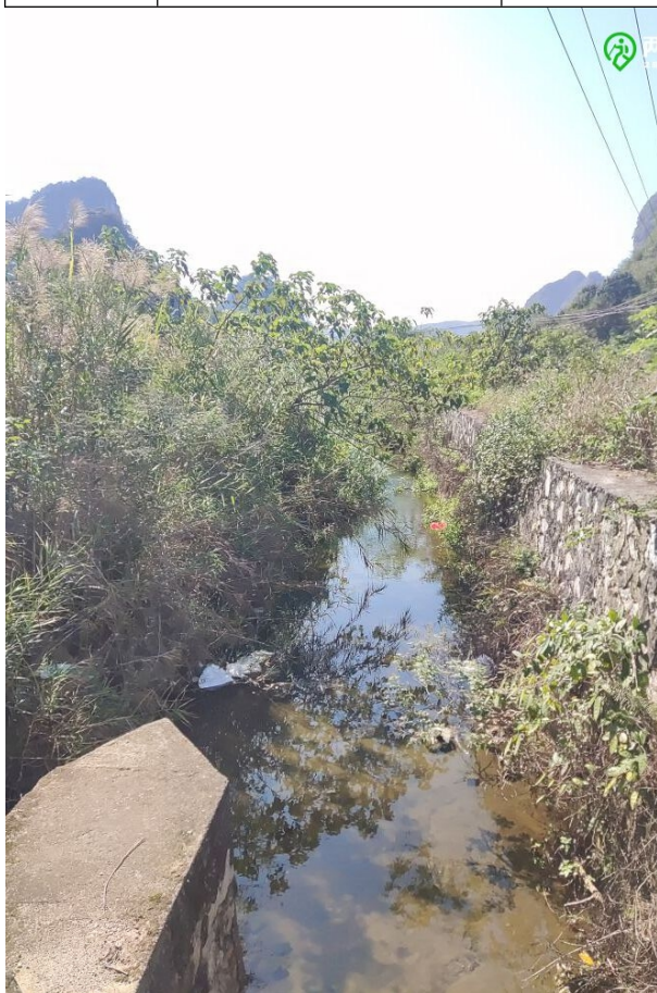
图 1.3-3 柳太公路桥堤防河道
