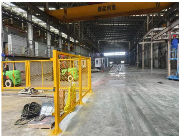
项目厂房内现状
