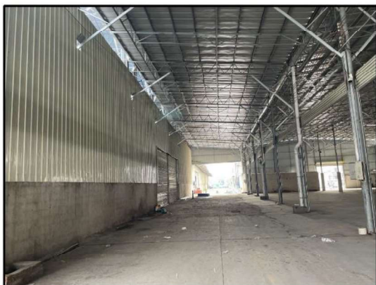
项目东北面厂房现状
