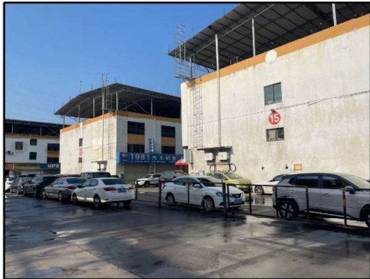
项目东面12#、15#厂房现状
