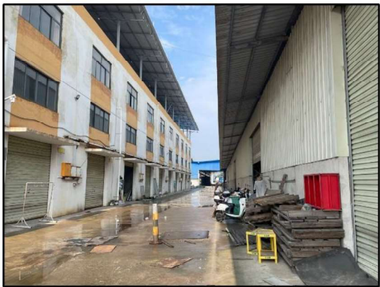
项目西北面10#厂房现状
