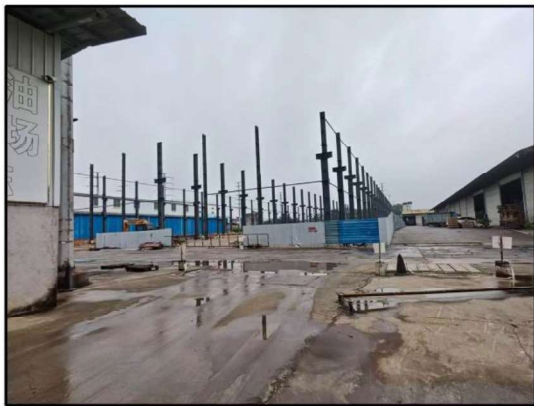
项目西面道路及在建厂房现状
