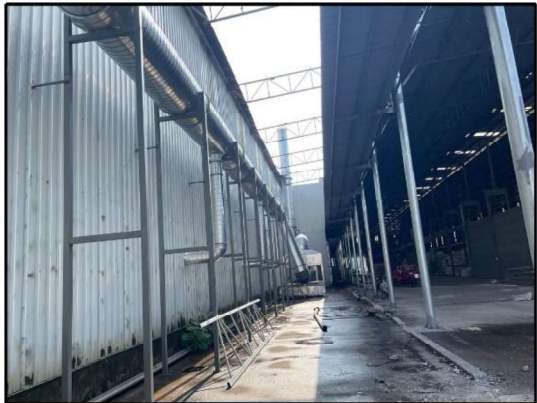
项目南面厂房现状
