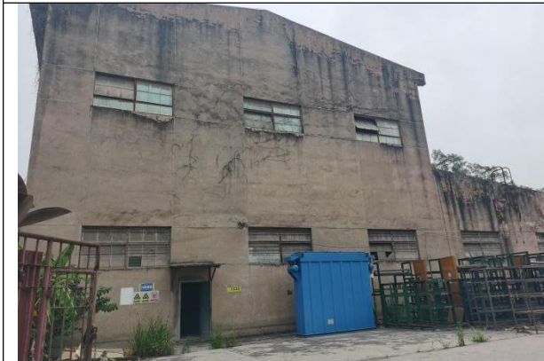
项目租赁仓库现状
