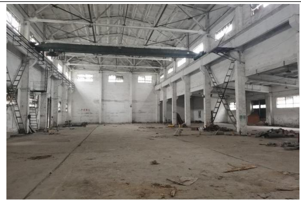
项目租赁仓库内部现状
