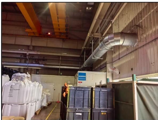
模具维修房及危险废物暂存间
