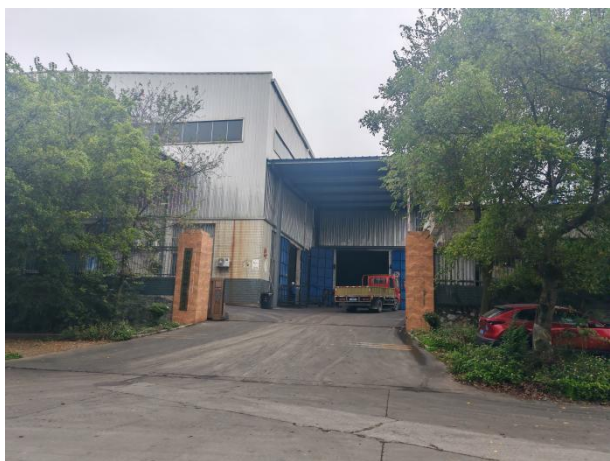
项目西面厂房
