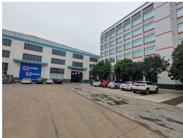
项目厂房及东面办公楼
