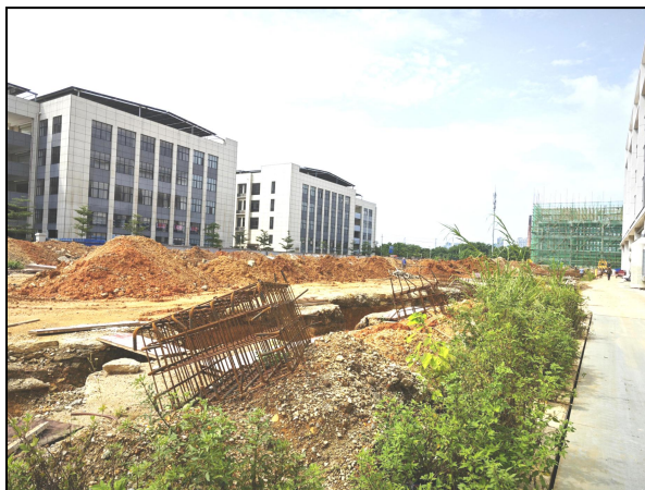
项目 3#厂房场地现状
