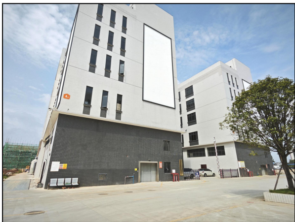
项目 4#、5#厂房现状
