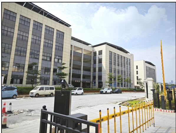
项目西面现状
