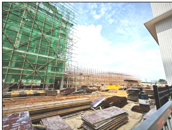
项目北面园区在建厂房
