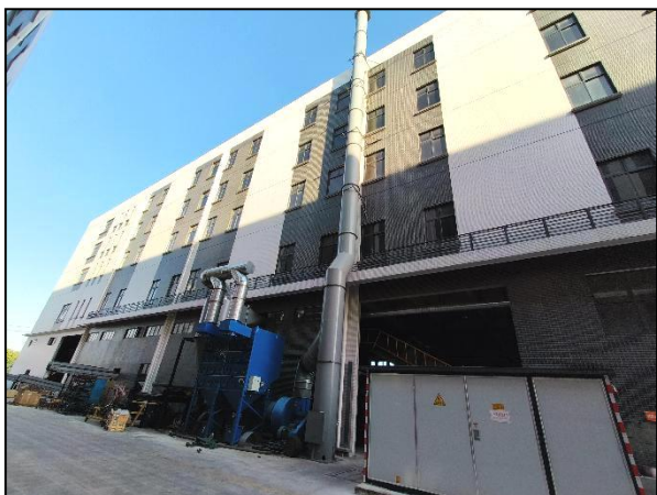
项目现有工程环保设施现状
