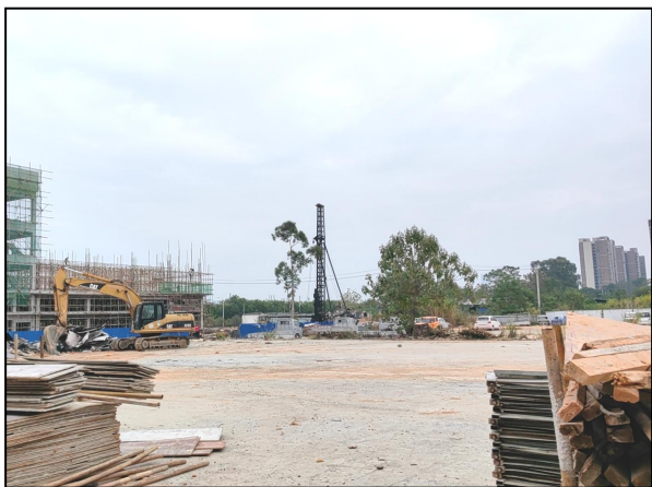
项目东面现状
