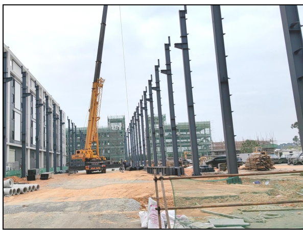
项目 6#厂房场地现状
