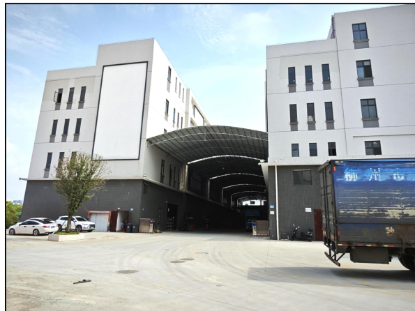
项目南面现状
