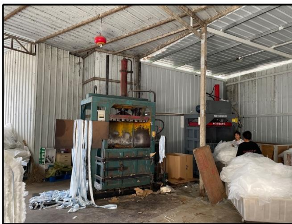
项目一般工业固体废物间
