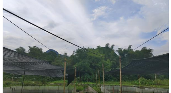
项目北面概貌
