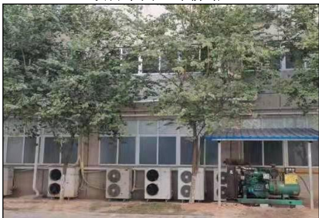
项目西面（5号厂房）
