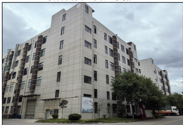
项目北面（1号、2号厂房）
