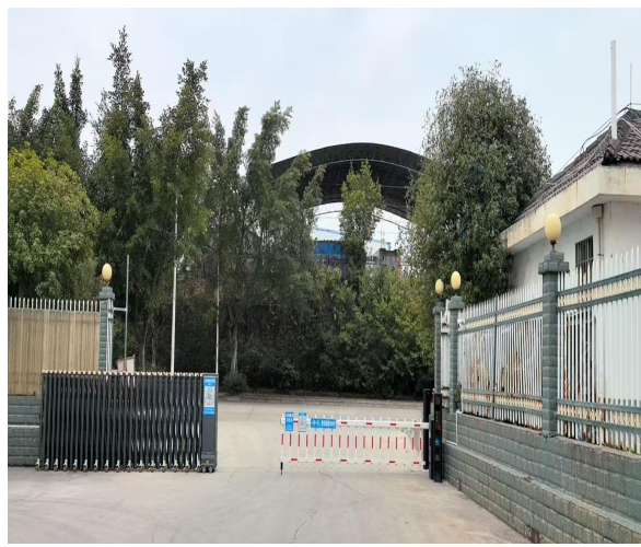
项目厂界西面（紧邻振业路）
