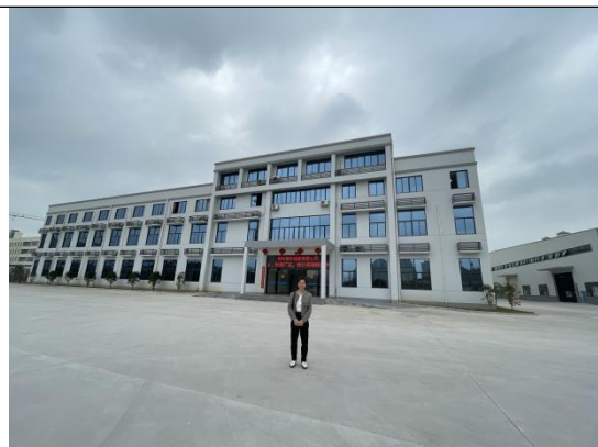
工程师现场踏勘照片
