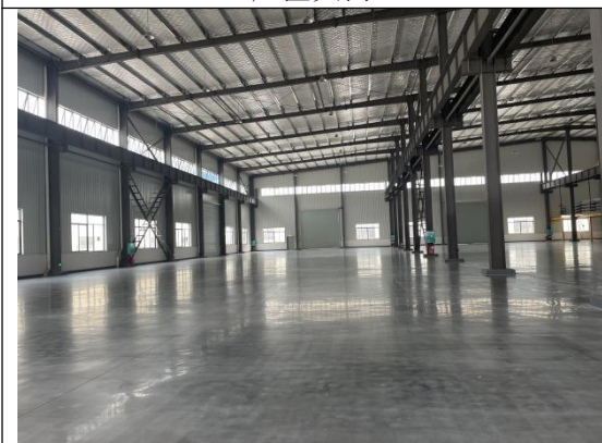
生产车间现状
